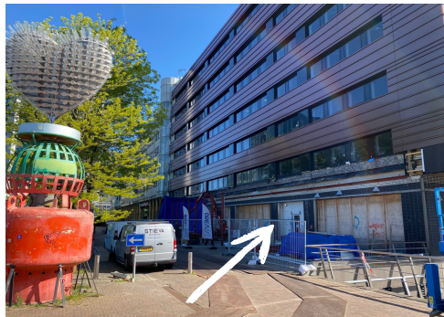
Ingang kantoorpand Busitel
